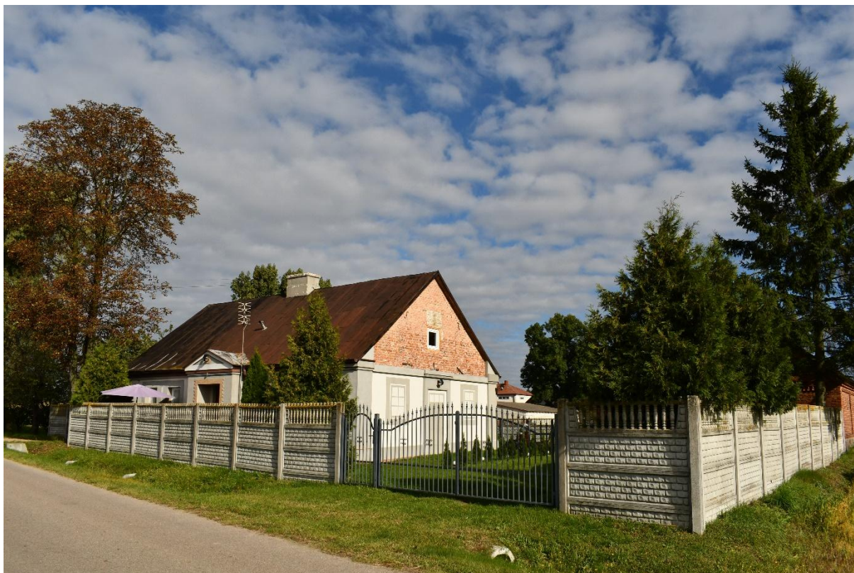
Fotografia 6. Zabudowa zagrodowa w Poczerninie – budynek ujęty w GEZ Fot. KANON Sp. z o.o. 09.2021
