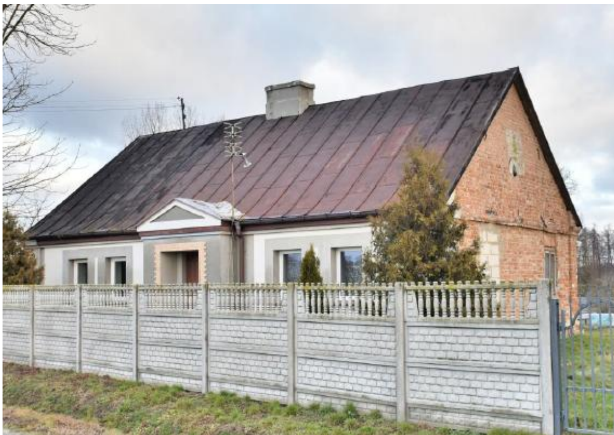
Fotografia 2. Ujęty w GEZ budynek mieszkalny nr 29 Źródło: Gminna ewidencja zabytków, karta adresowa zabytku nieruchomego; stan na: 15.09.2021]
